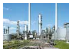
Contrôle de matériaux et inspection
